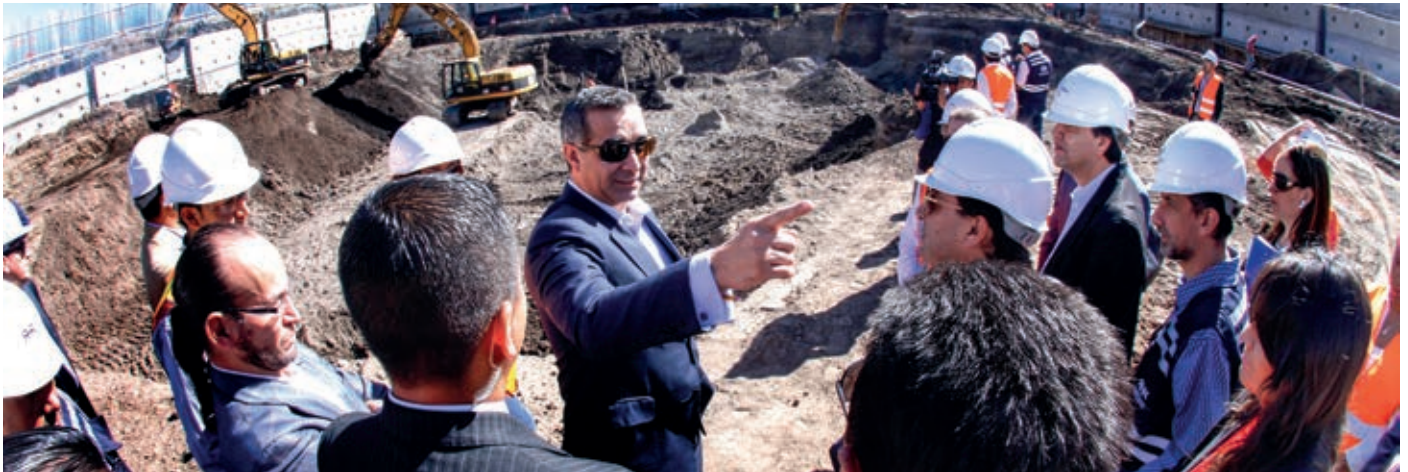
El 26 de junio último, el Presidente del CJ, Gustavo Jalkh, verificó el avance de las obras judiciales que se construyen en Quito.
